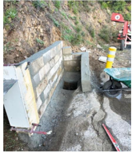
• Fabrication d'un muret sur le pont de Siagne afin d'éradiquer les stationnements sauvages et de canaliser les eaux de pluies
