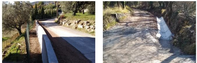
Il s'agit notamment de l'ancien chemin de Seillans à Camandre, où un mur de soutènement de la route s'est effondré. Ce mur, d'une hauteur de 2 mètres et d'une longueur de 25 mètres, a été reconstruit en béton armé.
