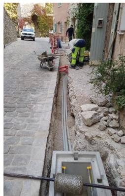
Lors des travaux de restauration de la façade située au n°3 rue du Valat, les câbles des différents réseaux ont dû être déposés pour refaire l'enduit. La commune a saisi l'opportunité d'effectuer l'enfouissement de ces réseaux : une tranchée a été faite avec la pose des différents fourreaux EDF et Orange, ainsi que des coffrets encastrés et des chambres de tirage. Les différents prestataires n'ont plus qu'à tirer leurs câbles.
